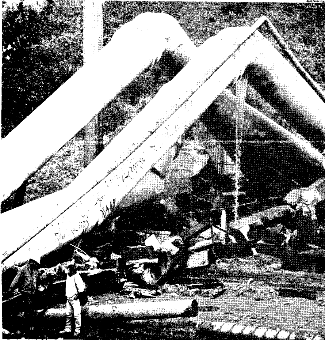
Funcionários da Sabesp trabalham para desobstruir a via férrea, junto à ponte do Socorro, na zona sul de São Paulo, onde ruiu uma estrutura de concreto
